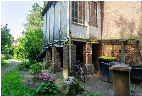
Abbildung 7/8: Notgesicherte Veranda
