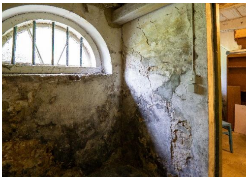
Abbildung 5/6: Risse, Feuchteschäden und Stützen im Keller
